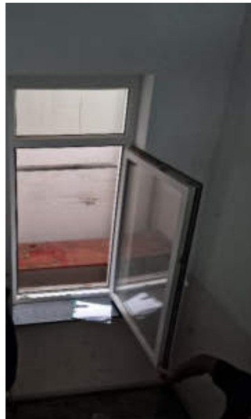
Fenster im Treppenhaus "Holzstraße 24" mit Blick in den Schacht
