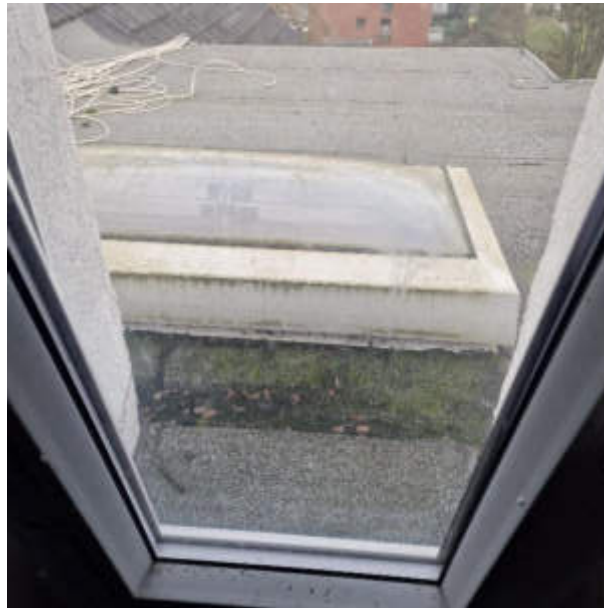
Blick auf die Lichtkuppel über dem Schacht „Holzstraße 24“
