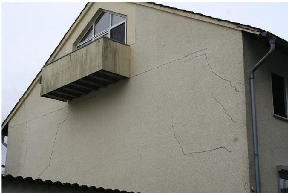
Bild 6: Straßenansicht / Nordostgiebel Rissbildungen der Fassade, erkennbar verschmiert / Schäden Dachüberstand
