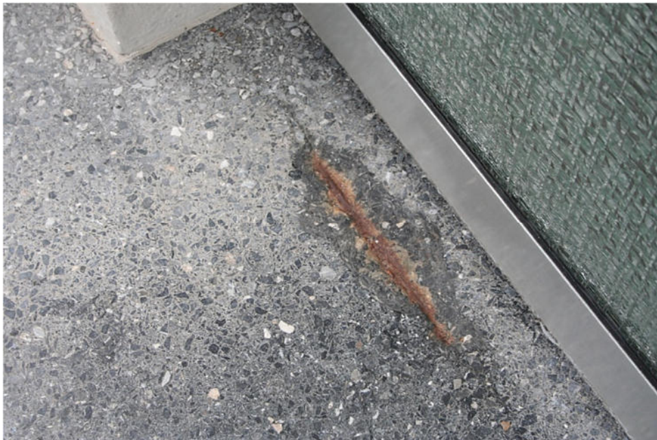
Bild 8: freiliegende Bewehrung im Eingangsbereich
