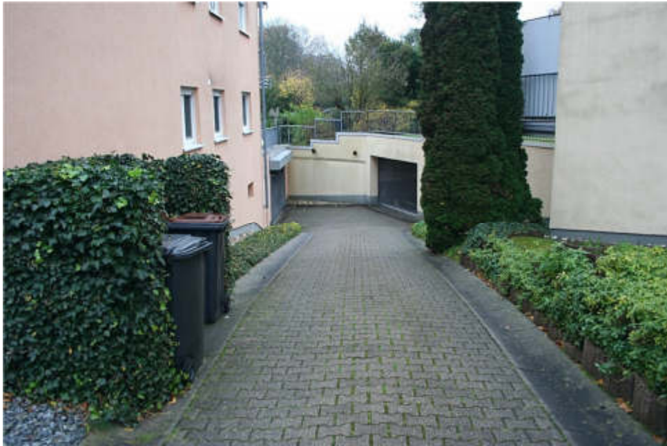
Bild 5: Zufahrt zu den Tiefgaragen der Häuser Beisenweg 1 bis 5
