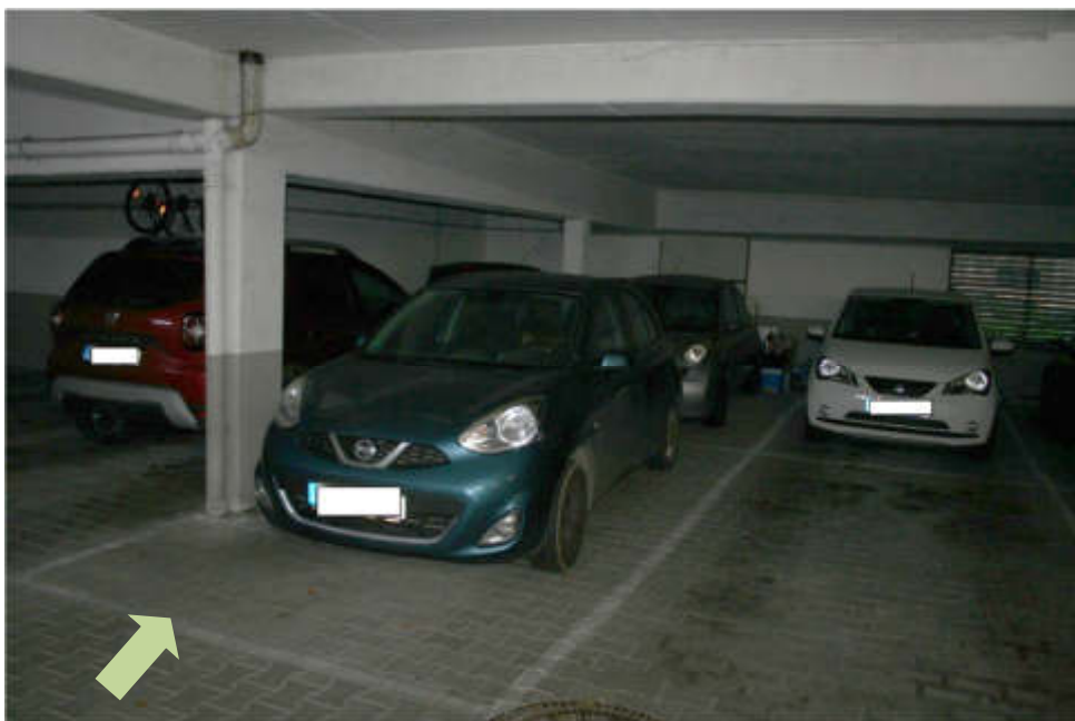
Bild 14: Tiefgaragen - Doppelstellplatz Nr. 33 zur Wohnung
