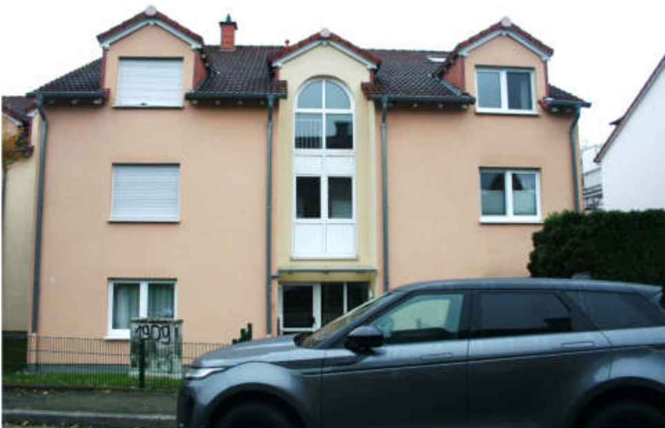
Bild 4: Straßenansicht Beisenweg 5 / Südwestansicht
