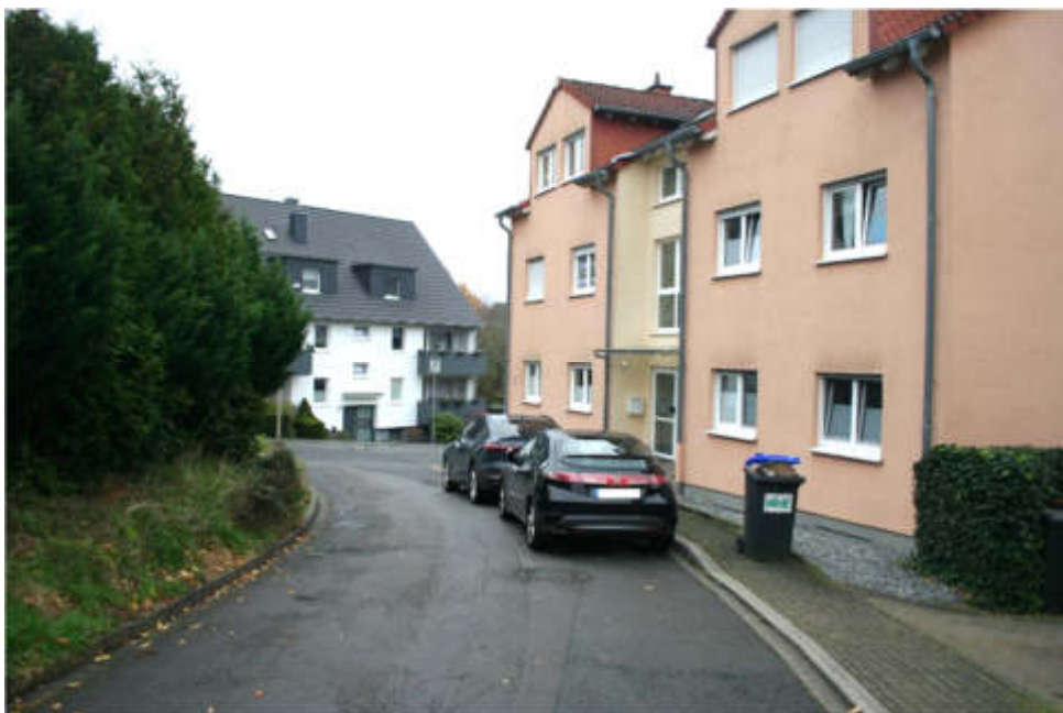
Bild 2: Umgebungsbebauung Beisenweg Richtung Norden
