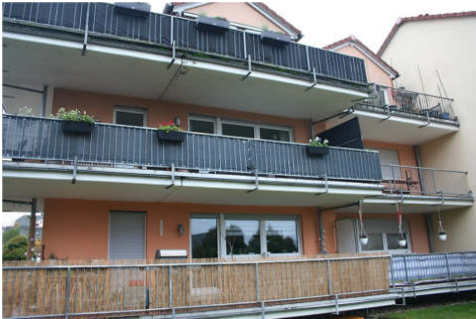
Bild 7: Rückansicht / Nordansicht Beisenweg 5
