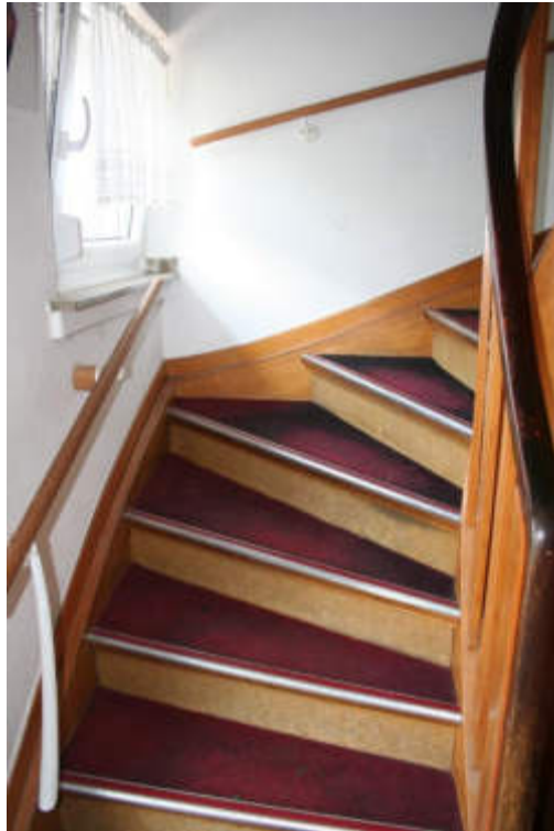
Bild 27: Treppenhaus / Treppe ins DG
