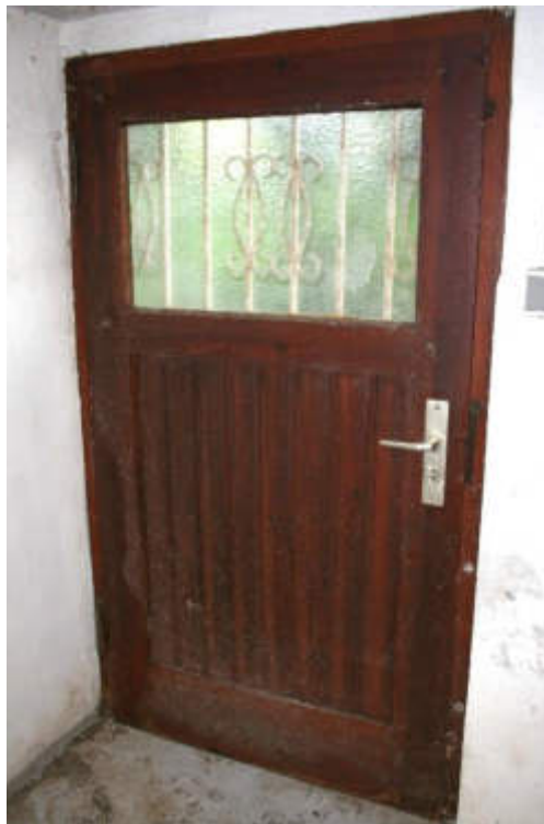
Bild 12: Kellertür zum rückseitigen Garten
