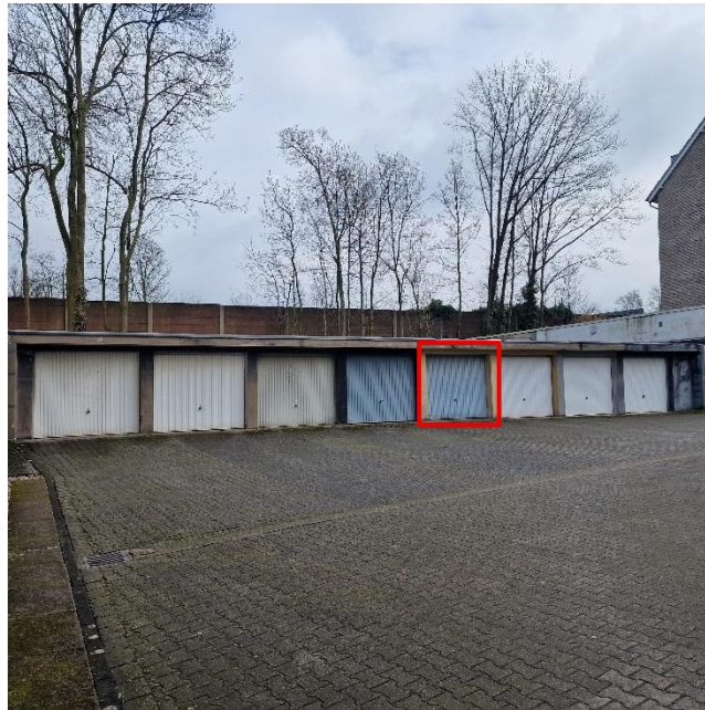
Garage mit Hoffläche (teilweise)
