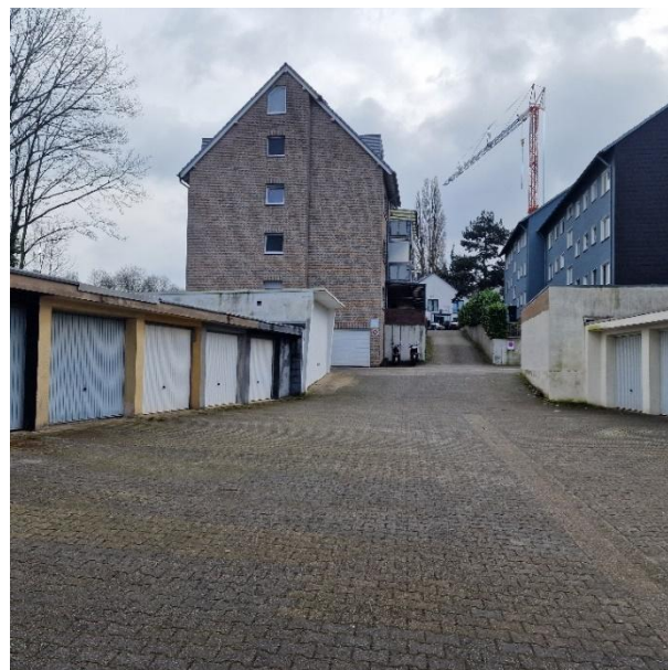
Hoffläche (teilweise) mit Zufahrt zu begünstigten Grundstücken (Recht zum Befahren mit PKW)
