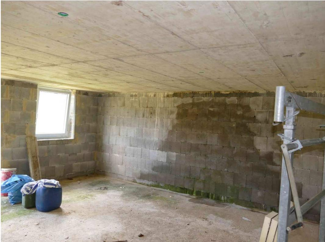
Bild 14: Auffeuchtung Außenwand Anbau auf Kellerniveau
