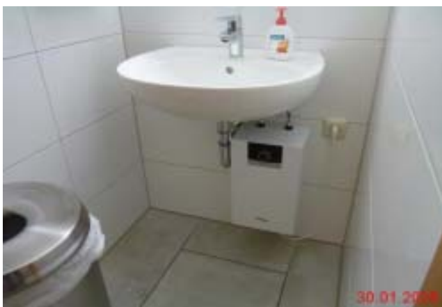
Abb. 17 Sanitäre Anlagen, 2. Obergeschoss
