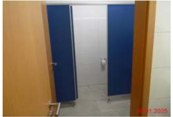
Abb. 16 Sanitäre Anlagen, 2. Obergeschoss
