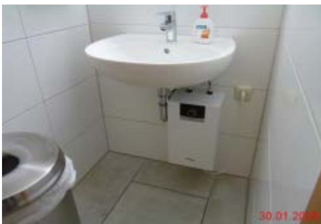
Abb. 17 Sanitäre Anlagen, 2. Obergeschoss
