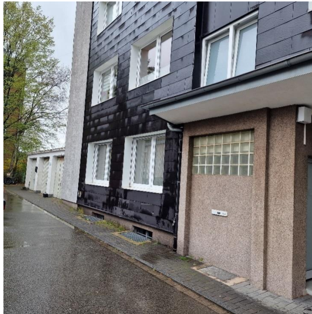
Zufahrt zu den Garagen
