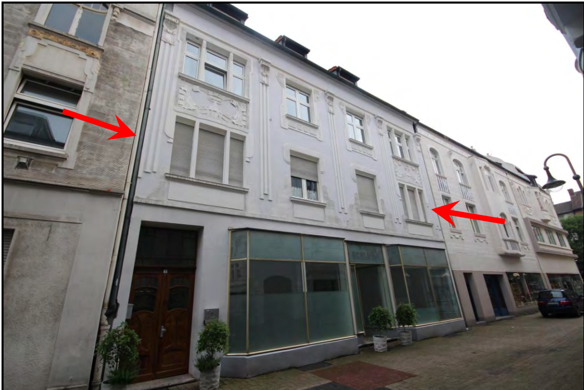
Bild 6: Ansicht von Südwesten
