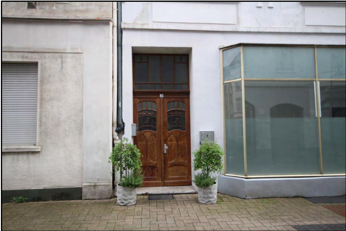
Bild 5: Eingangstür zum Treppenhaus und zum rückwärtigen Garten
