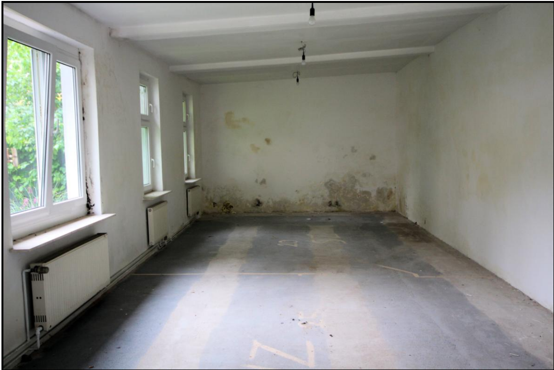
Bild 30: Hinterer Anbau des Teileigentums Nr. 4
