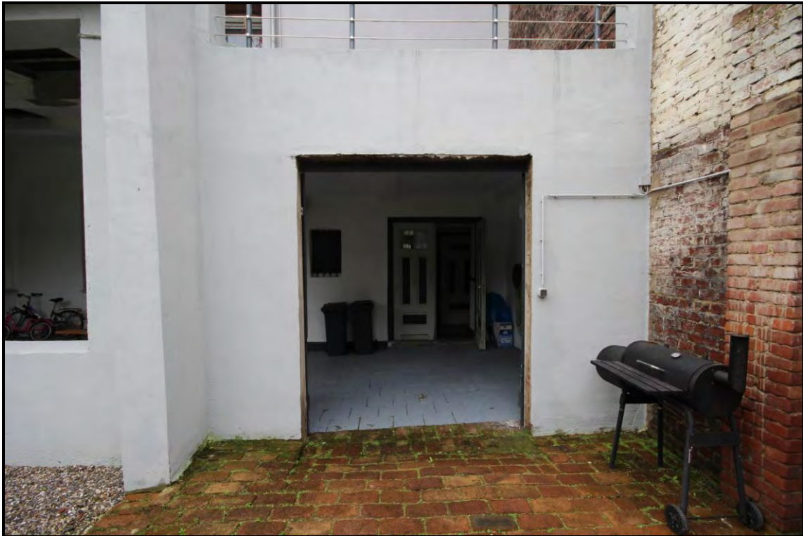
Bild 9: Durchgang zum Treppenhaus
