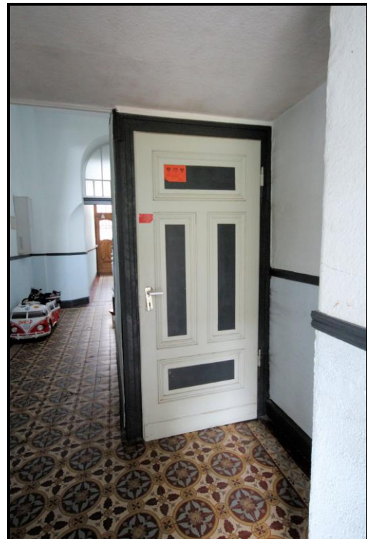
Bild 19: Zugang zum Kellergeschoss
