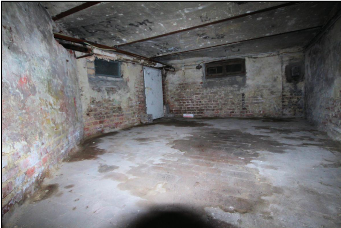
Bild 23: Einer der beiden Kellerräume des Teileigentums Nr. 4
