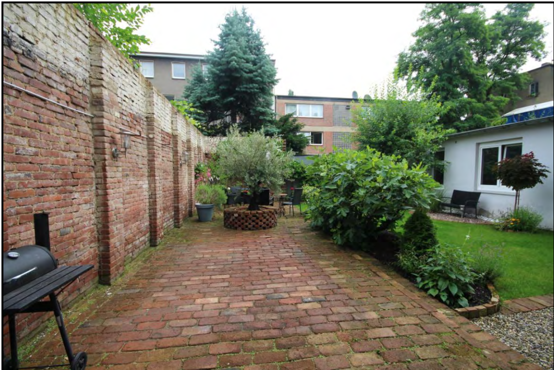
Bild 14: Bereich des abgebrochenen Lagergebäudes und Papierschuppens
