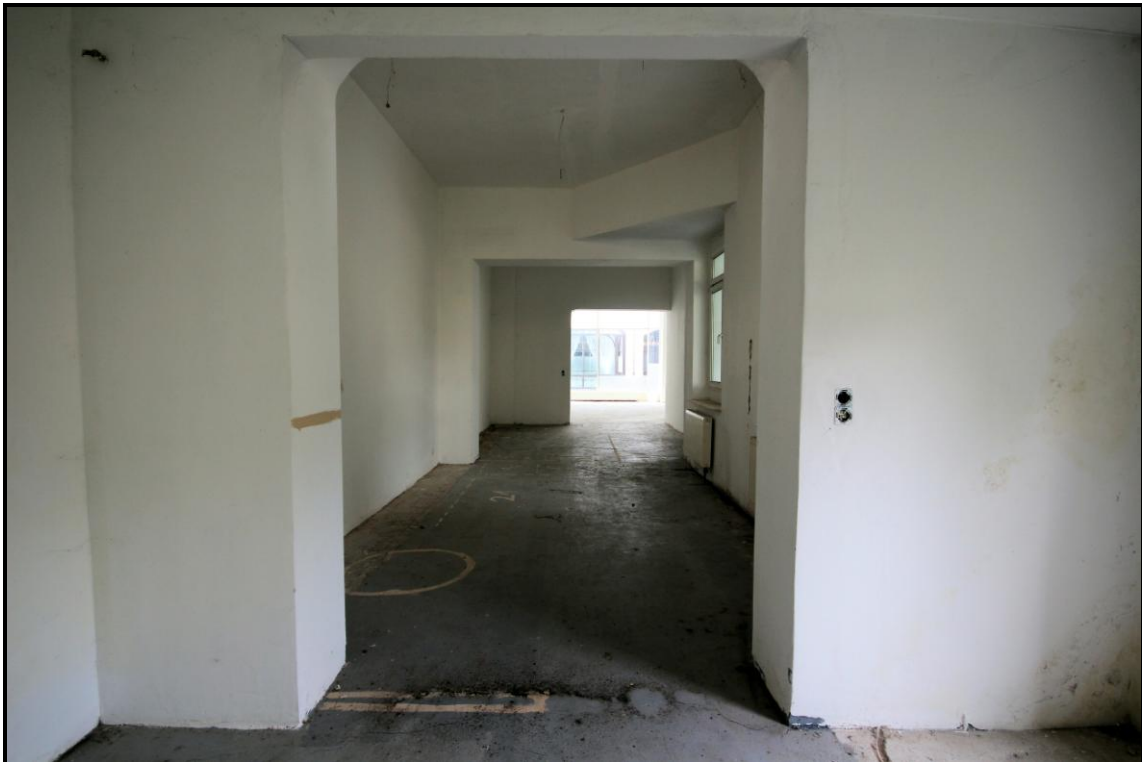
Bild 31: wie vor, jedoch Blickrichtung zur Straßenseite
