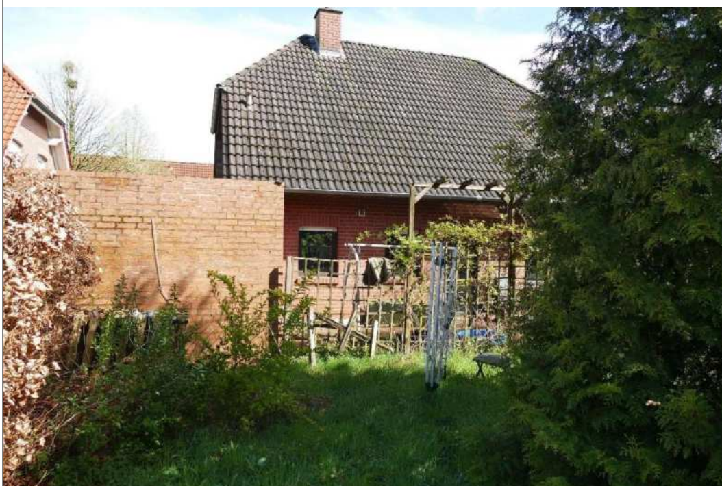
H4 | Ansicht der rückwärtigen Fassade und der Garage
