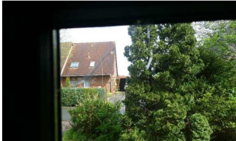
B7 Diele: Glasfüllung in der Haustür beschädigt
