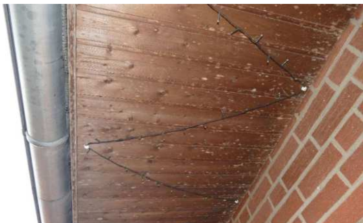
A2 Zustand der Dachüberstände (Traufe)
