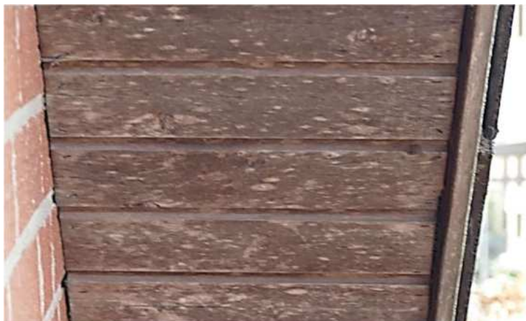
A1 Zustand der Dachüberstände (Ortgang)
