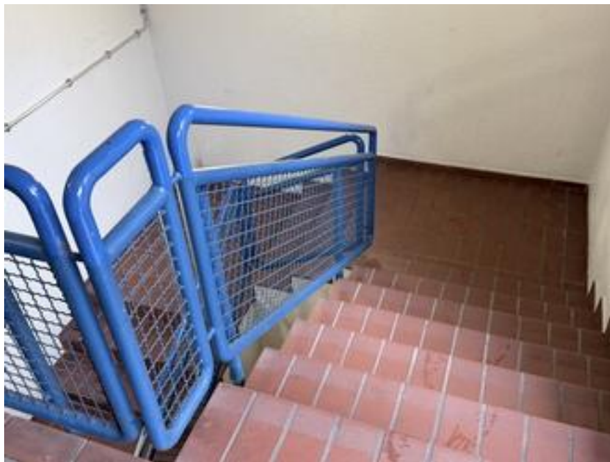
Treppenhaus der Tiefgarage
