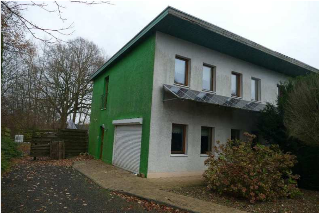
F1 | Ansicht des Bürogebäudes mit Zuwegung zum hinteren Grundstücksteilbereich
