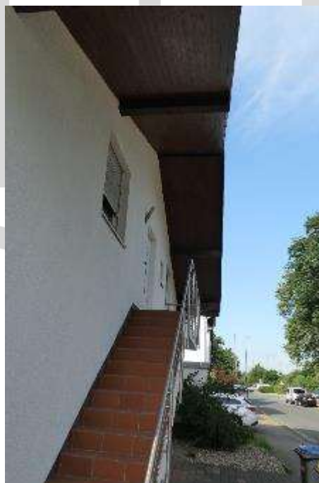
Bild 6 Treppe zum Obergeschoss
