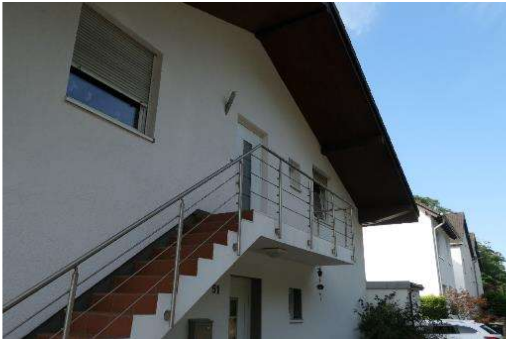
Bild 5 Geschosstreppe zur Wohnung Nr. 2
