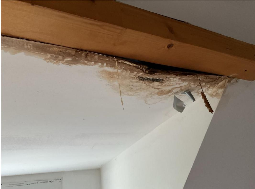
Bild 10: Feuchtigkeitsschaden an Dachgaube
