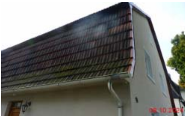
Abb. 3 Mansarddacheindeckung
