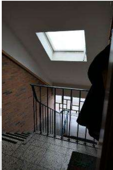
Bild 27 Treppenhaus im Dachgeschoss
