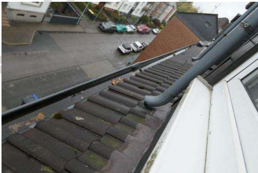
Bild 22 Blick auf die Dacheindeckung
