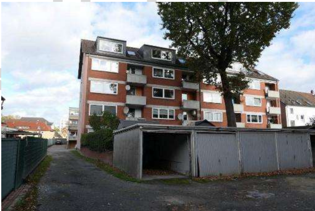
Bild 8 Blick auf die Rückseite der Wohnhäuser über die Garagen
