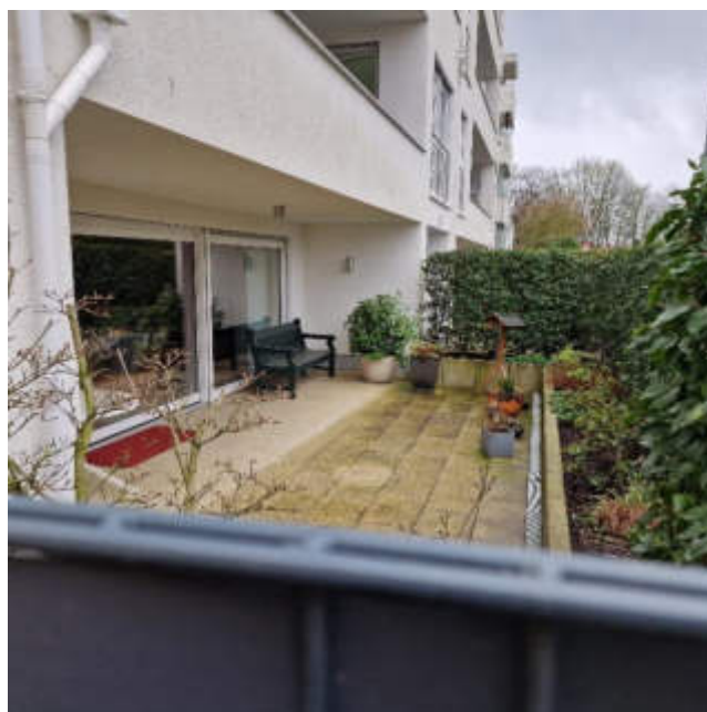
Blick auf die Terrasse der Wohnung Nr. 1
