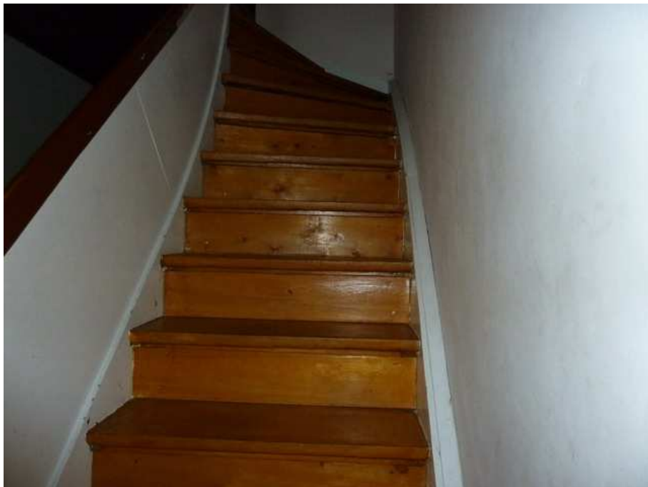
Treppe im Erdgeschoss
