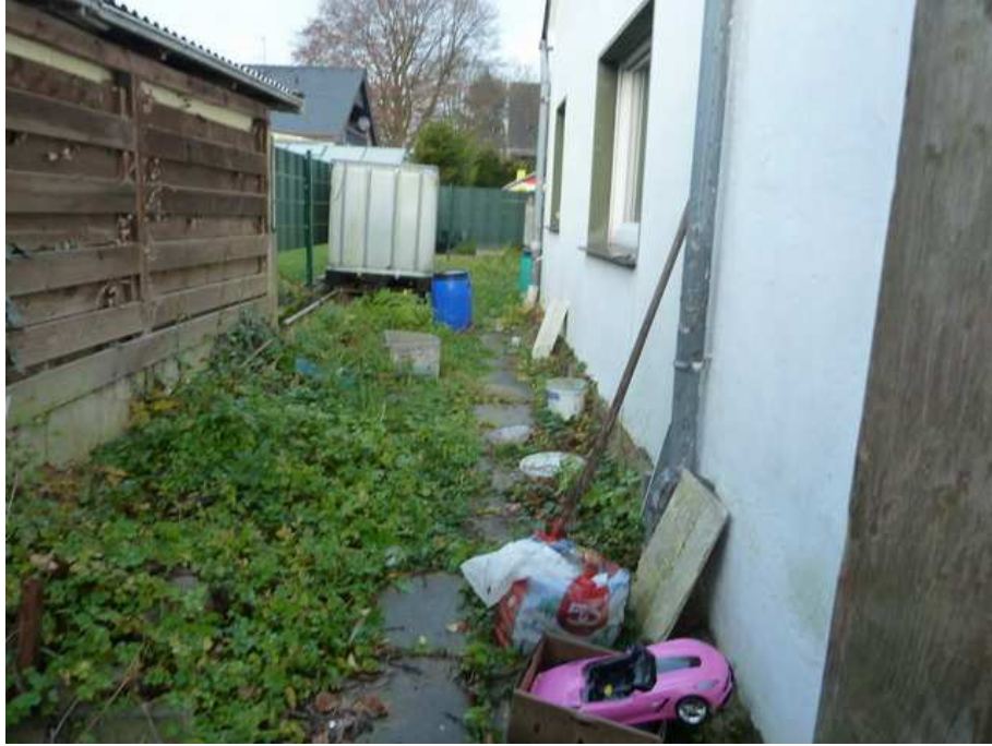
Grundstückansicht westlich vom Haus
