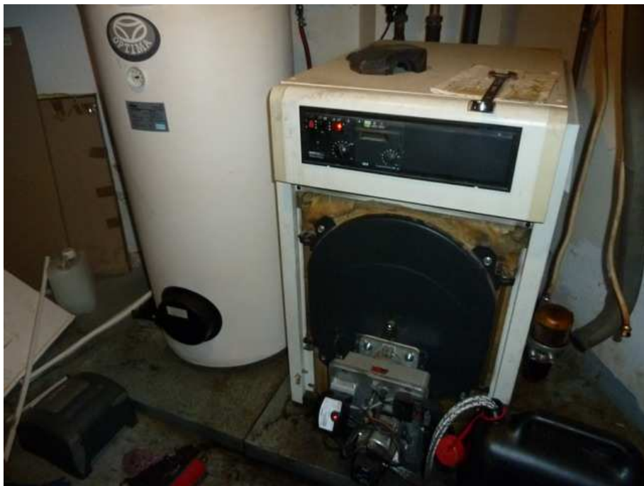
Ölzentralheizung (defekt)
