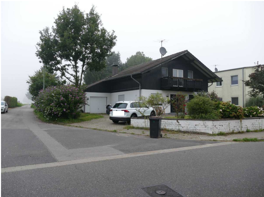
Bild 1: Profilansicht (Blick nach Nordosten)
