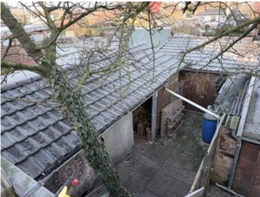
Nebengebäude an der westlichen Grundstücksgrenze
