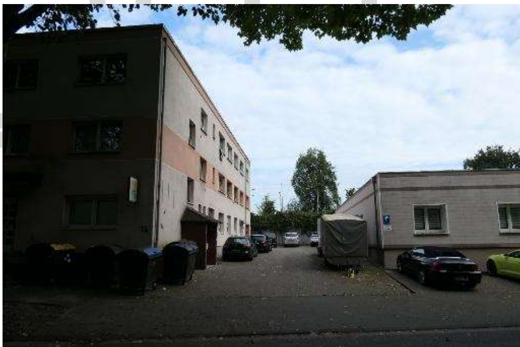
Bild 8 Zugang zu den Treppenhäusern
