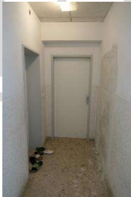
Bild 34 Flur im Treppenhaus
