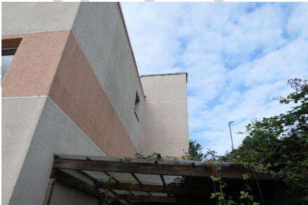
Bild 16 Ansicht des überbauten Aufzugschachtes
