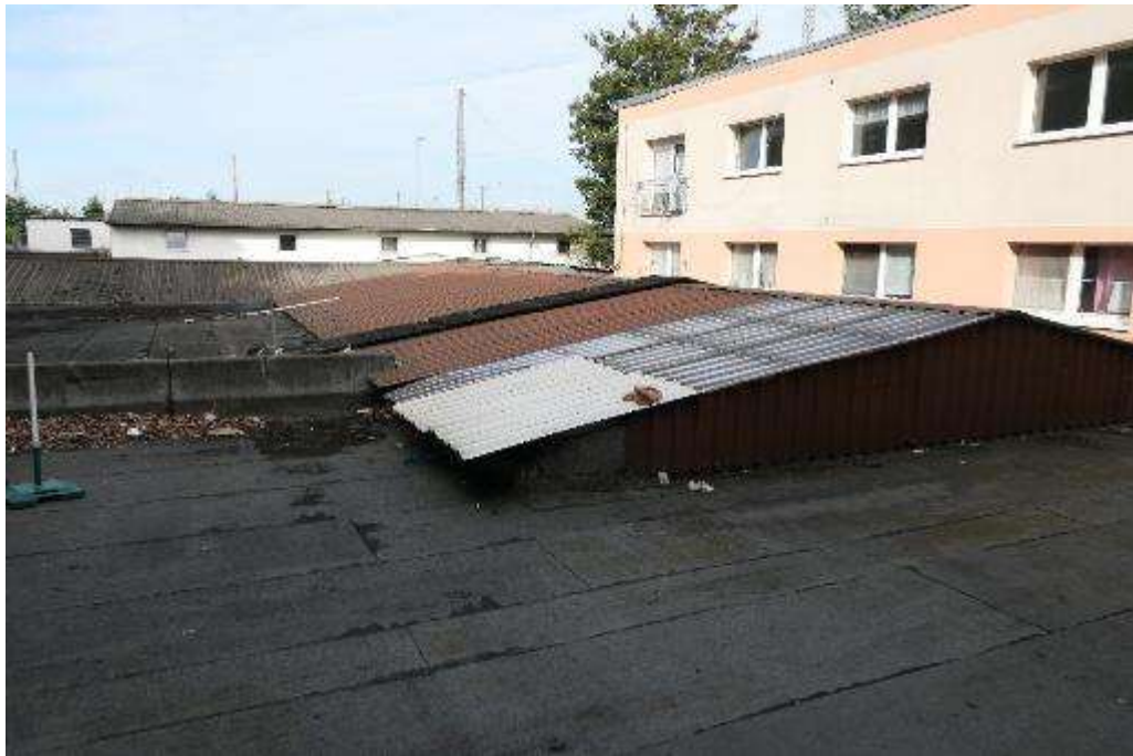
Bild 31 Überdachung des Hofes
