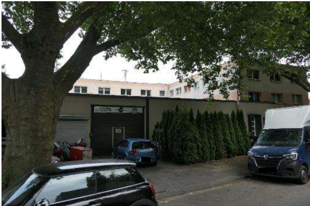
Bild 5 eingeschossiger Gebäudeteil mit Büronutzung
