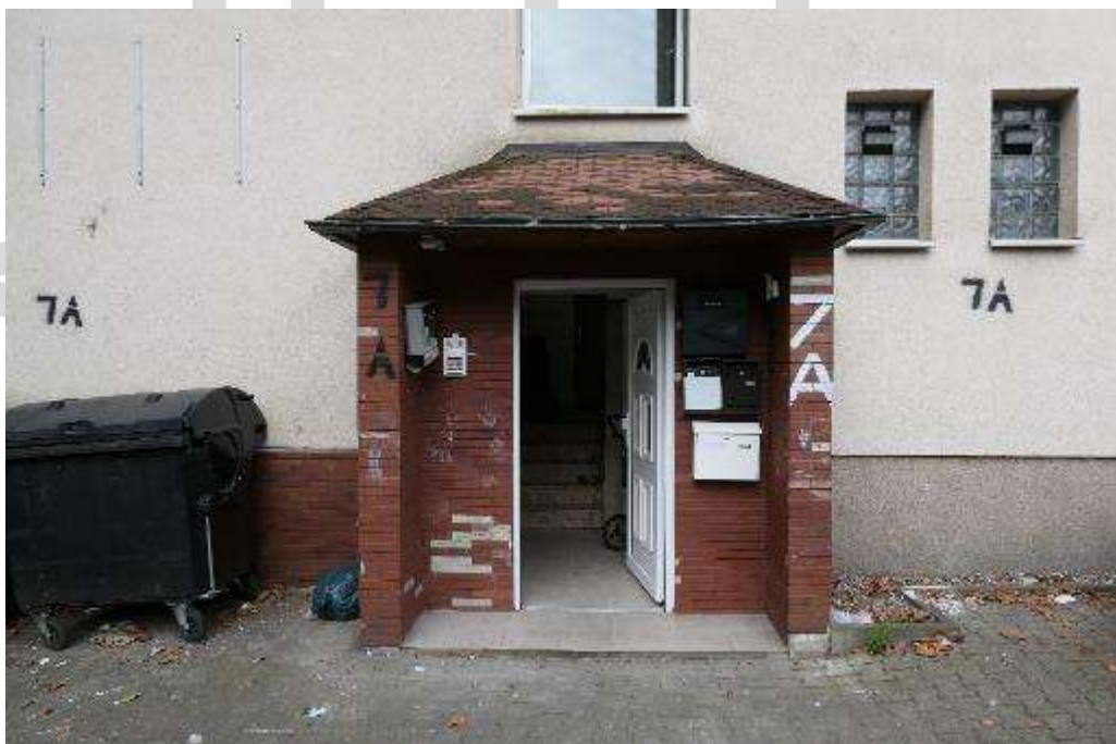
Bild 12 Hauseingang zum ersten Treppenhaus
