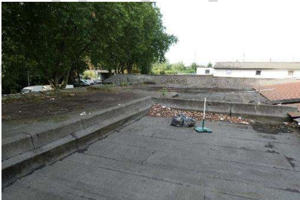
Bild 32 Bitumendach des straßenseitigen Bauteils
