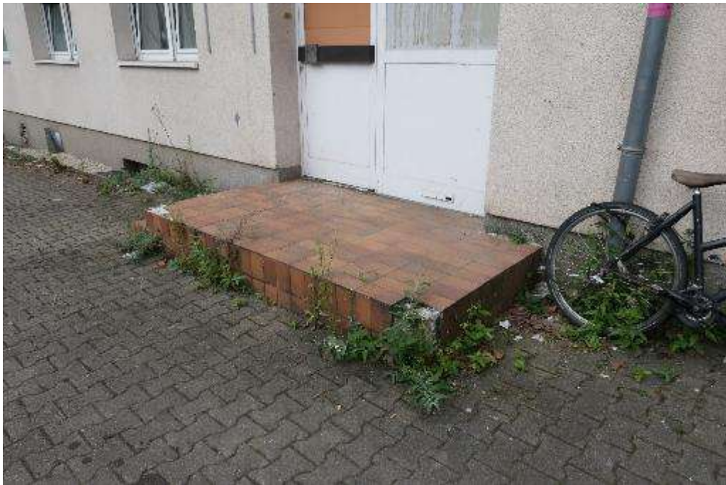
Bild 19 seitlicher Zugang zu einer Büroeinheit
