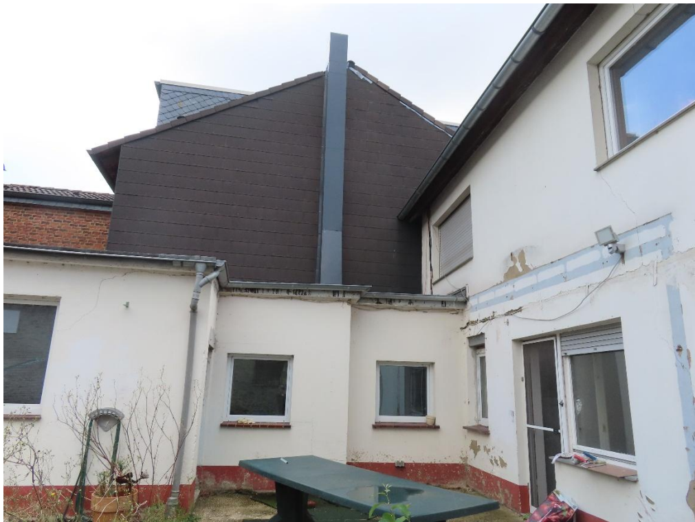
Abb. 3 + 4: Rückansicht von Wohnhaus und Anbau
