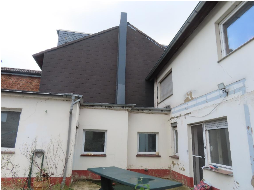
Abb. 3 + 4: Rückansicht von Wohnhaus und Anbau
