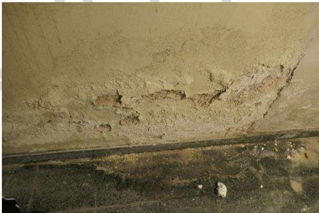
Bild 22 Feuchtigkeitsschaden im Treppenhaus
