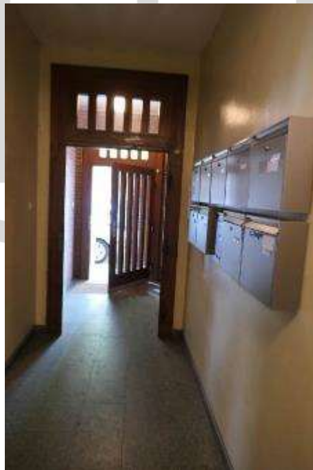
Bild 12 Hauseingang Flur, Hauseingangstür schließt nicht
