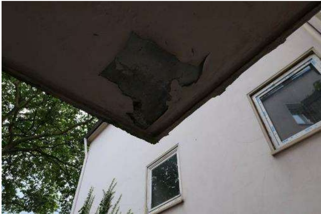
Bild 21 sanierungsbedürftiger Balkon
