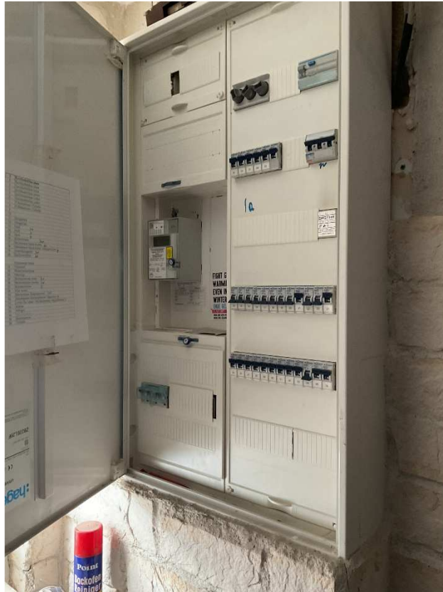
Bild 10: Elektroanschluss-/ Sicherungskasten
