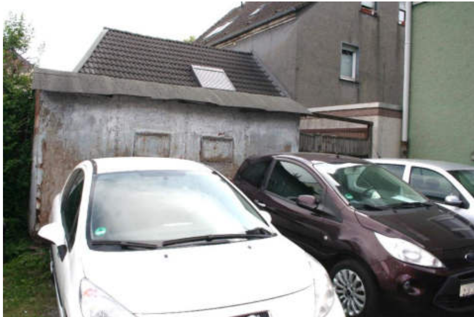
Bild 9: rückseitige Hoffläche / Blechgarage auf dem Grundstück
