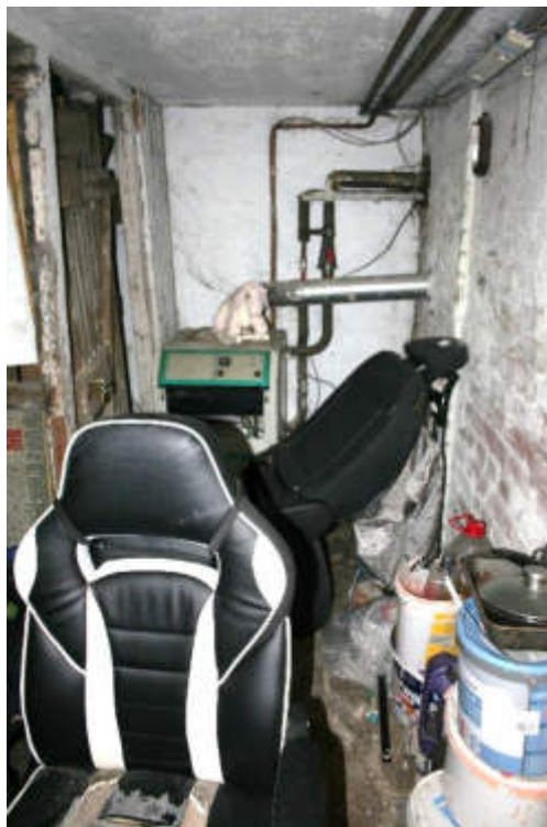
Bild 14: Abstellkeller Whg. EG links / Heizung der Wohnung
