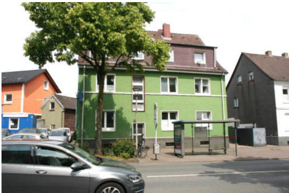
Bild 4: Straßenansicht Hörder Straße / Südostansicht
