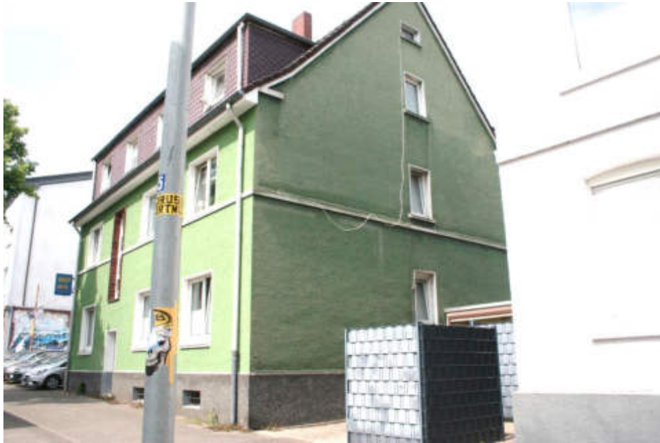
Bild 5: Straßenansicht Hölder Straße / Südostansicht und Nordostgiebel
