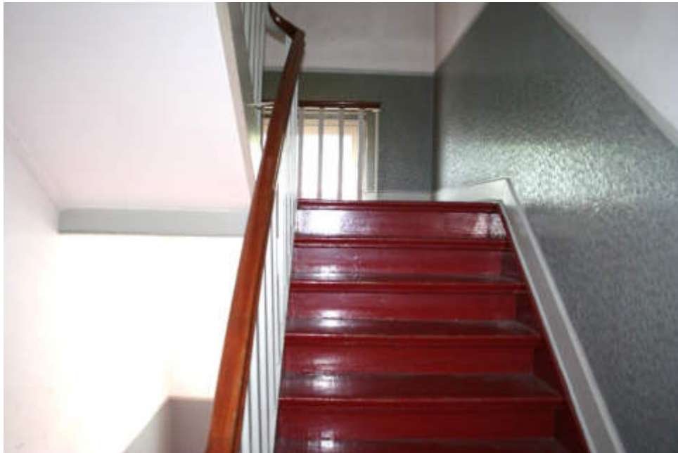
Bild 31: Treppe ins Dachgeschoss
