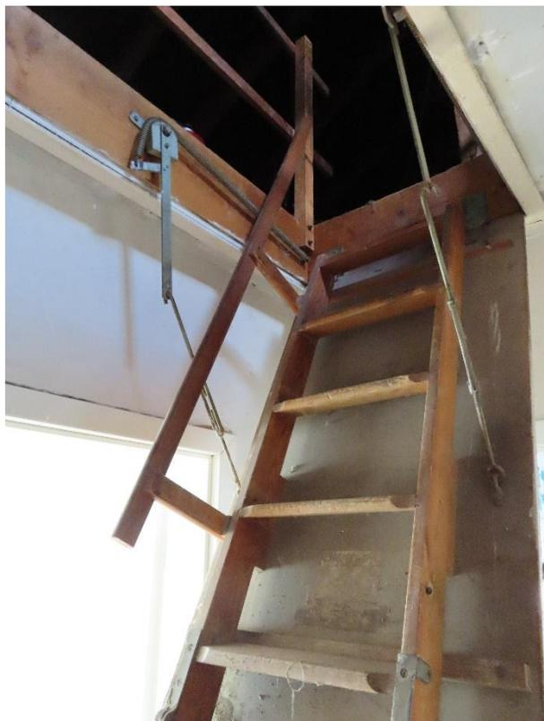
Abb. 14: Einschubtreppe in das nicht ausgebaute Dachgeschoss
