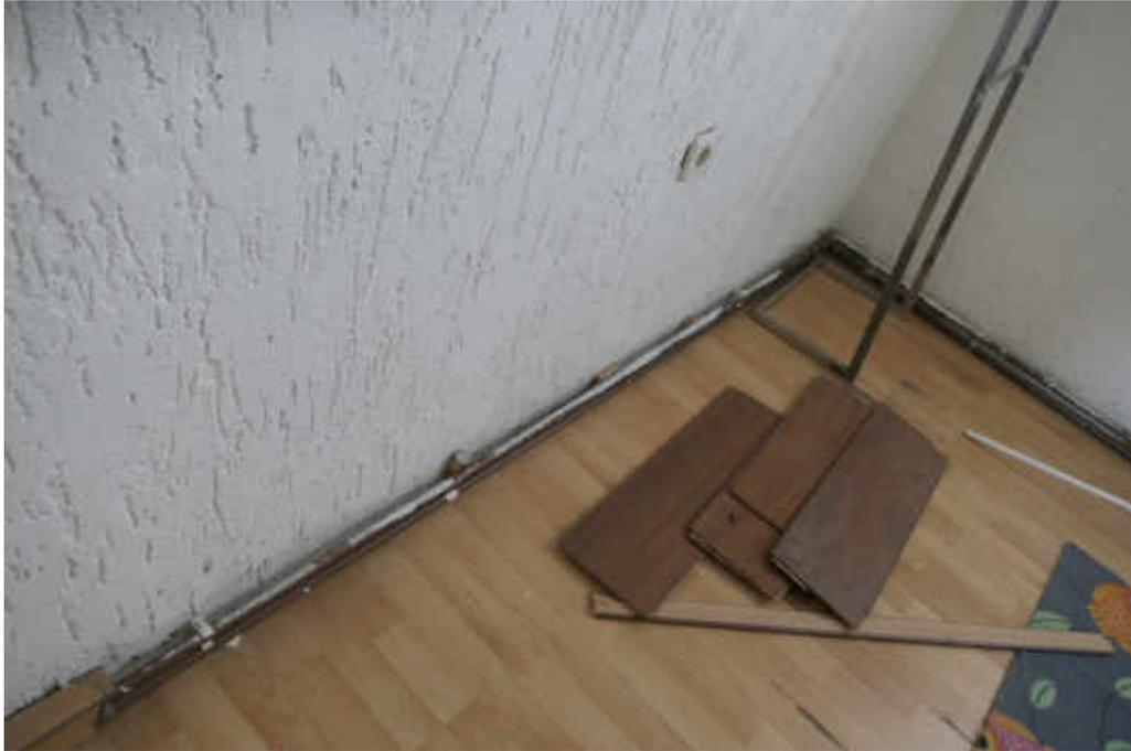
Bild 27 Schäden am Laminat
