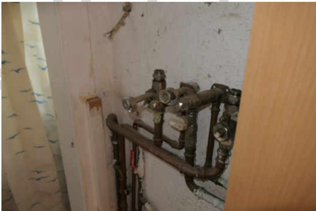
Bild 24 Heizungsanschlüsse für Gastherme
