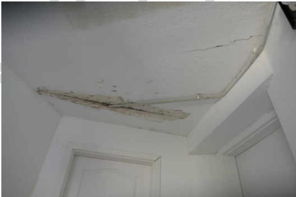
Bild 18 Wasserschaden im Treppenhaus
