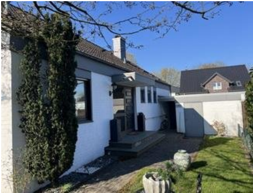
Links, der Hauseingang, rechts die Rückseite der Garage
