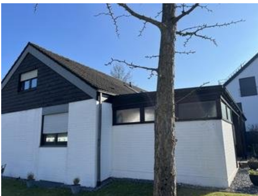
Überdachte Terrasse zur Straße
