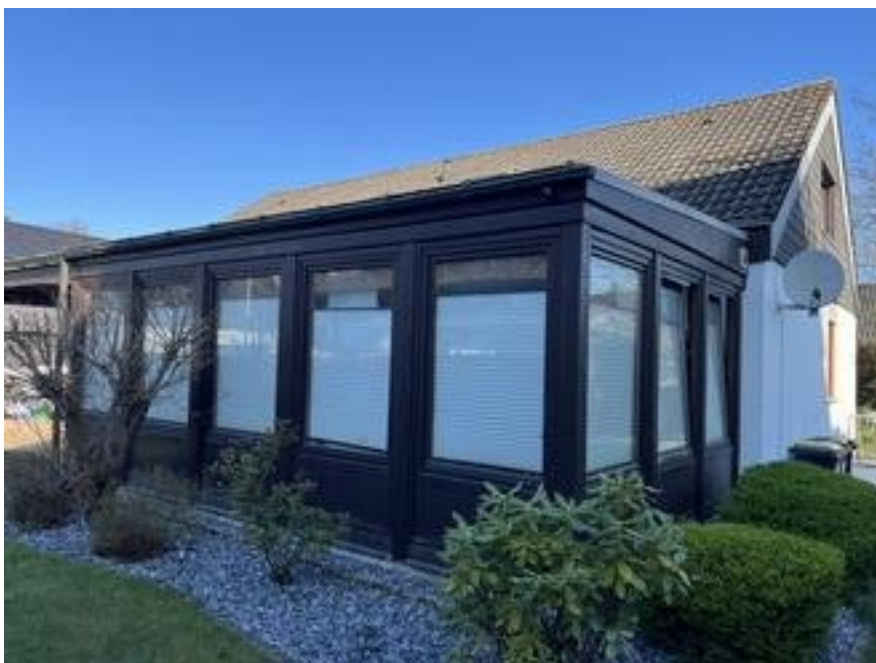
Beheizter Wintergarten, Bj. ca. 1988
