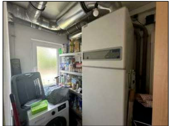
Erdgeschoss: Hauswirtschaftsraum / Heizung
