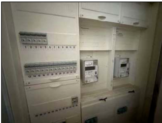
Elektrik: Sicherungskasten
