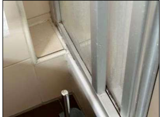
Schimmelbildung an der Duschartrennung
