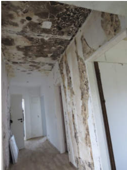
Feuchtigkeitsschaden/Schimmel
