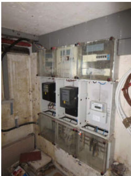
E-Zählerinstallation (KG)
