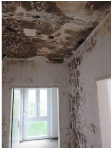
Feuchtigkeitsschaden/Schimmel
