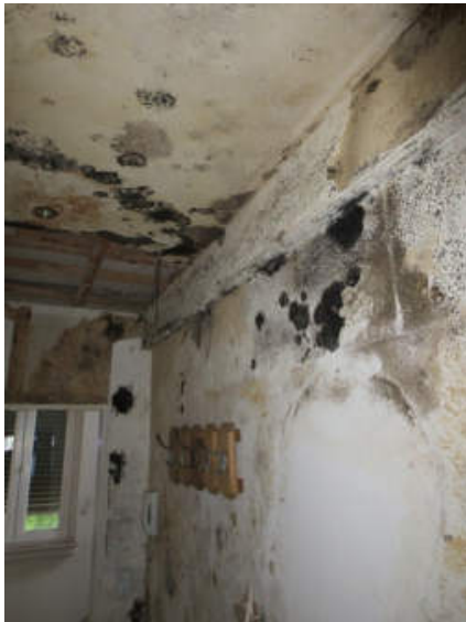
Feuchtigkeitsschaden/Schimmel
