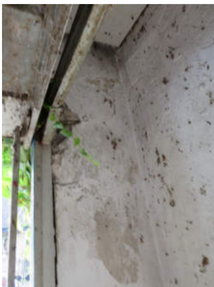
Feuchtigkeitsschäden
