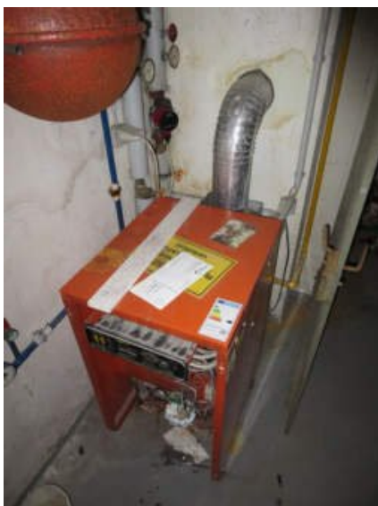
überalterter Heizungskessel
