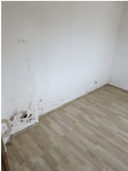
Feuchtigkeitsschaden/Schimmel
