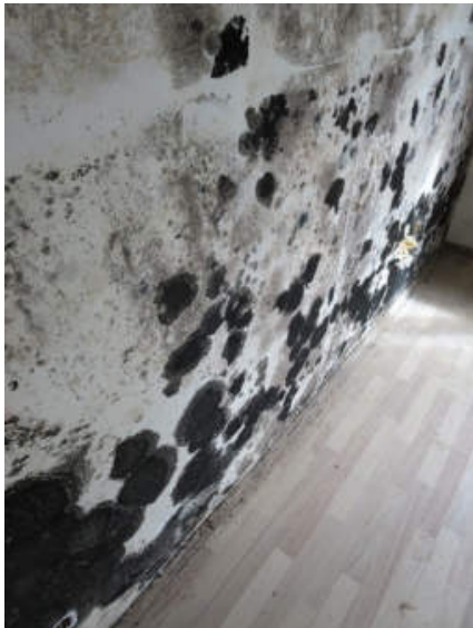
Feuchtigkeitsschaden/Schimmel
