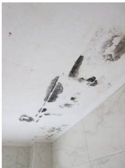
Feuchtigkeitsschaden/Schimmel
