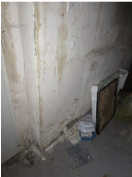
Feuchtigkeitsschaden/Schimmel
