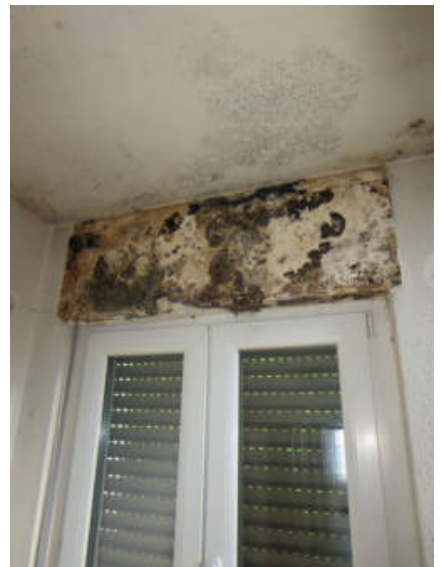
Feuchtigkeitsschaden/Schimmel
