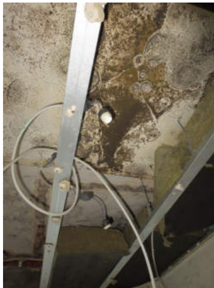
Feuchtigkeitsschaden/Schimmel
