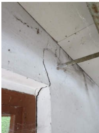
Mauerwerksrisse
