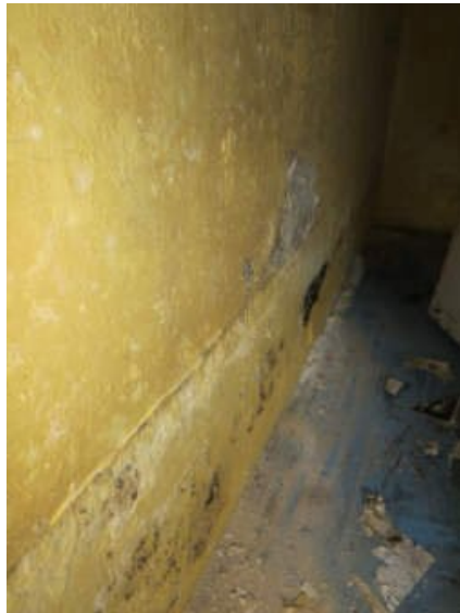
Feuchtigkeitsschaden/Schimmel
