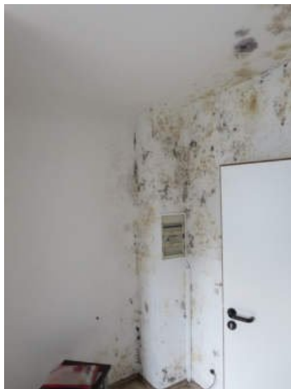
Feuchtigkeitsschaden/Schimmel
