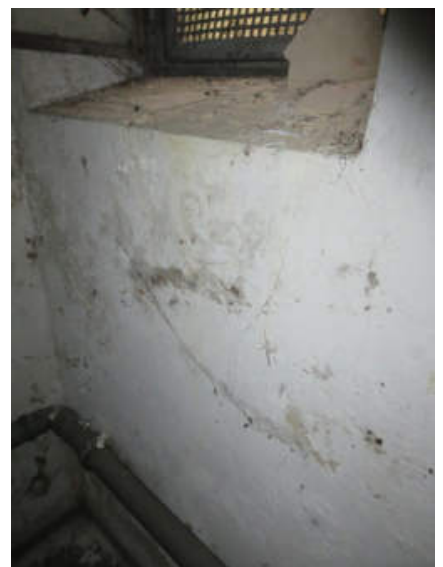
Feuchtigkeitsschaden/Schimmel
