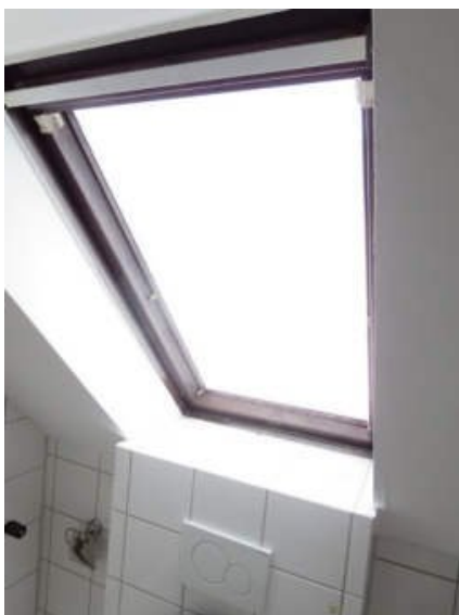
überaltertes Dachflächenfenster
