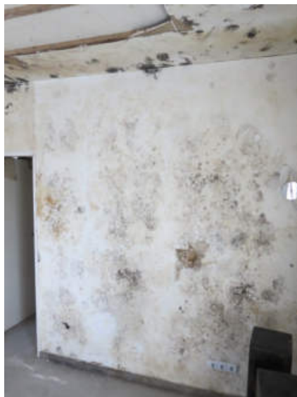
Feuchtigkeitsschaden/Schimmel
