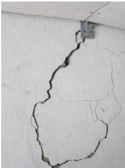
Mauerwerksrisse
