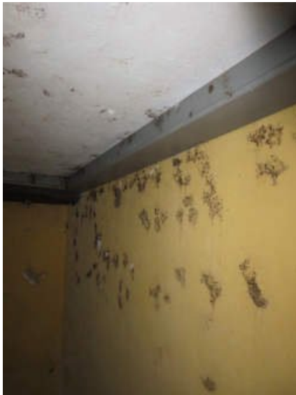
Feuchtigkeitsschaden/Schimmel
