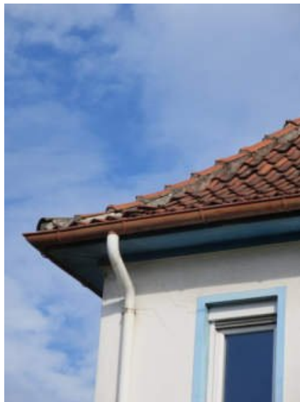
schadhafte Dachfläche
