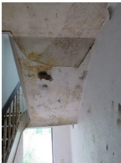
Feuchtigkeitsschaden/Schimmel
