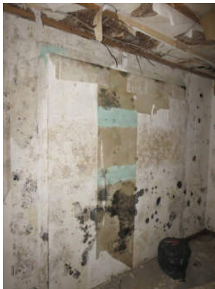
Feuchtigkeitsschaden/Schimmel
