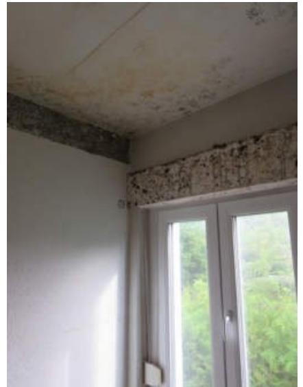
Feuchtigkeitsschaden/Schimmel
