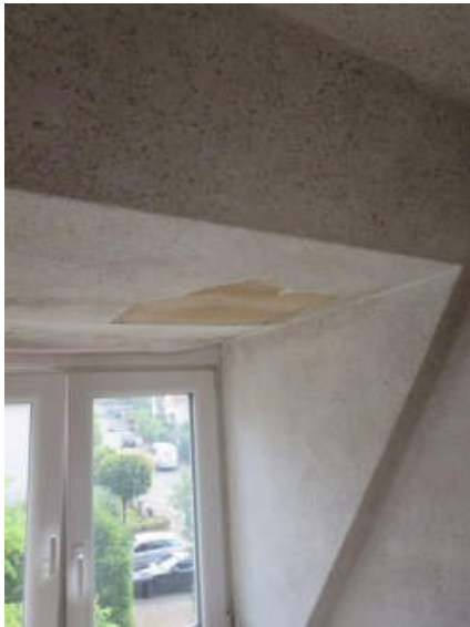
Feuchtigkeitsschaden/Schimmel
