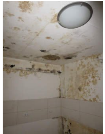
Feuchtigkeitsschaden/Schimmel
