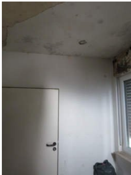
Feuchtigkeitsschaden/Schimmel
