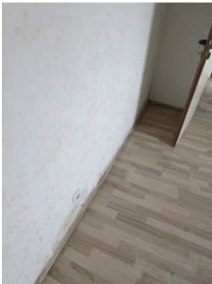
Feuchtigkeitsschaden/Schimmel
