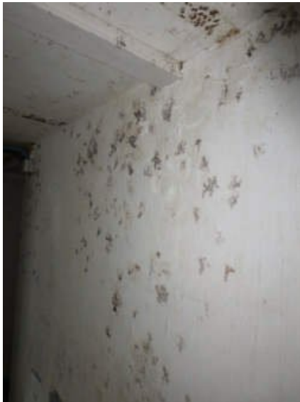
Feuchtigkeitsschaden/Schimmel
