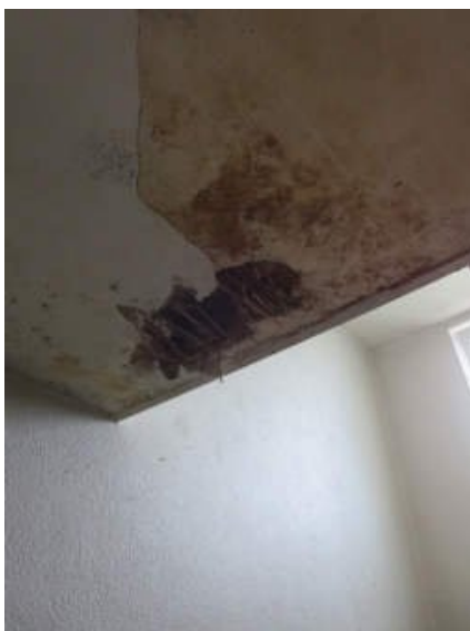
Feuchtigkeitsschaden/Schimmel
