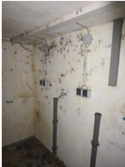
Feuchtigkeitsschaden/Schimmel
