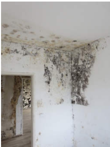
Feuchtigkeitsschaden/Schimmel
