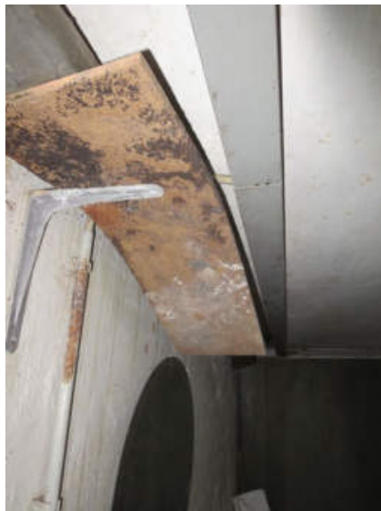
Feuchtigkeitsschaden/Schimmel
