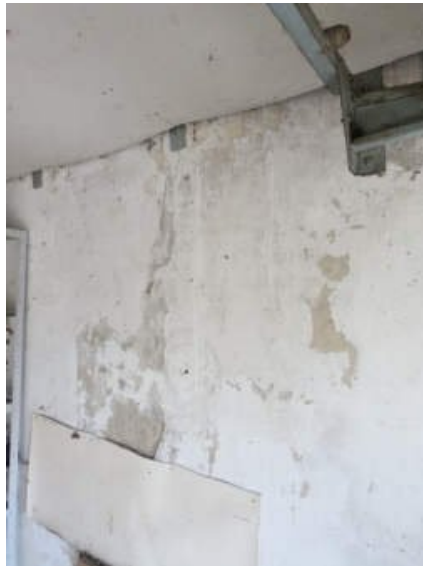
Feuchtigkeitsschäden
