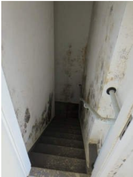
Feuchtigkeitsschaden/Schimmel
