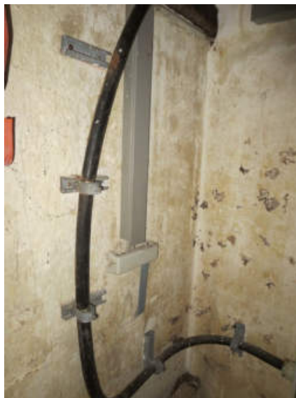
Feuchtigkeitsschaden/Schimmel
