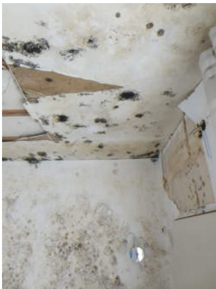
Feuchtigkeitsschaden/Schimmel
