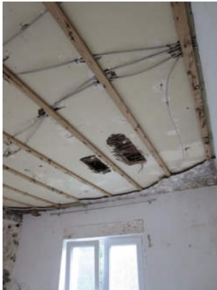
Feuchtigkeitsschaden/Schimmel
