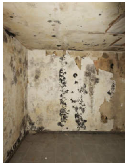
Feuchtigkeitsschaden/Schimmel
