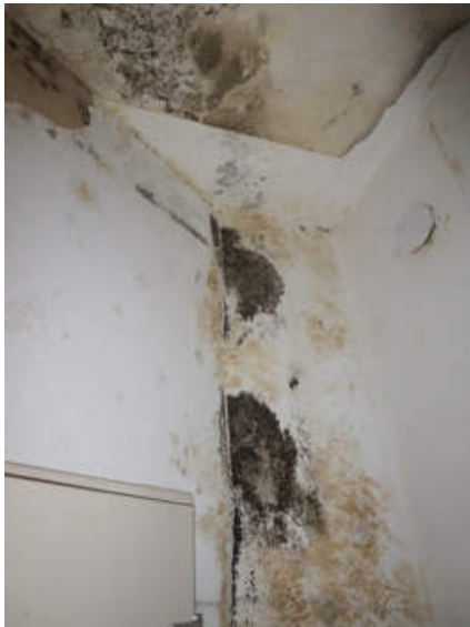
Feuchtigkeitsschaden/Schimmel
