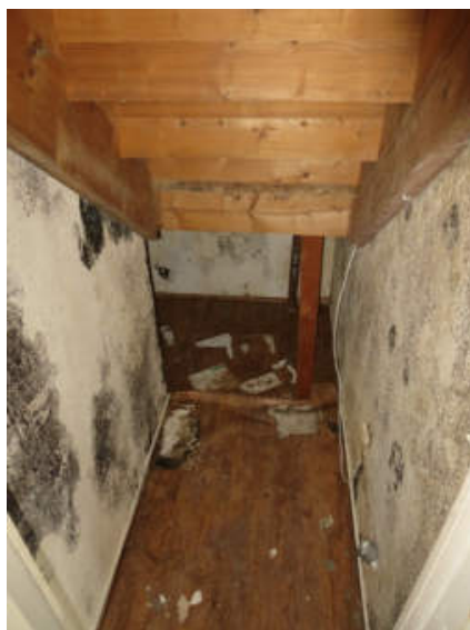
Abstellfläche unter Treppe (EG)
