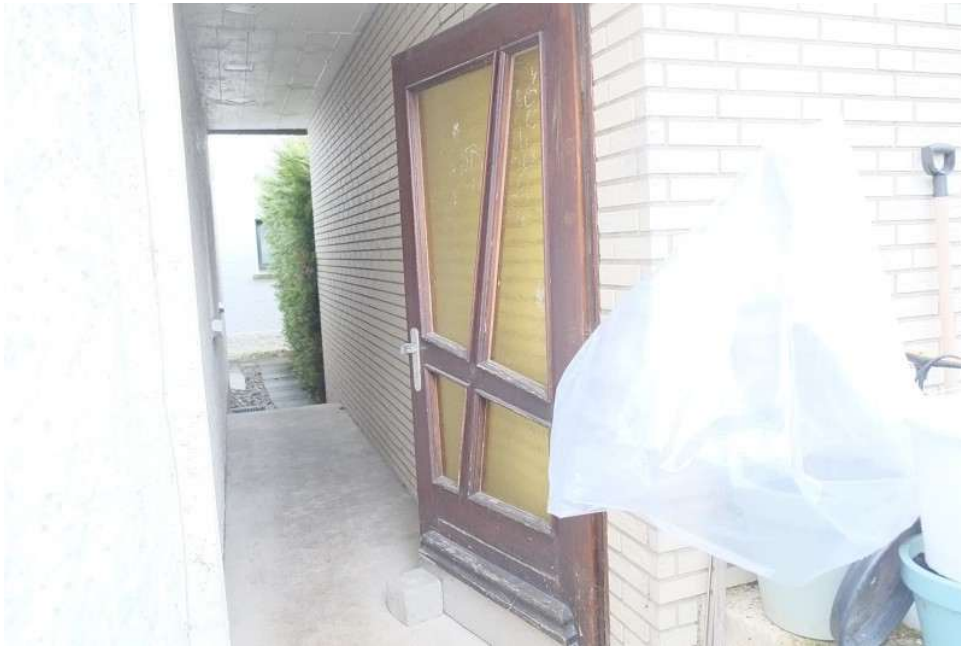
Bild 3: Durchgang zwischen den Wohnhäusern Teutoburger Weg 49a und 49b
