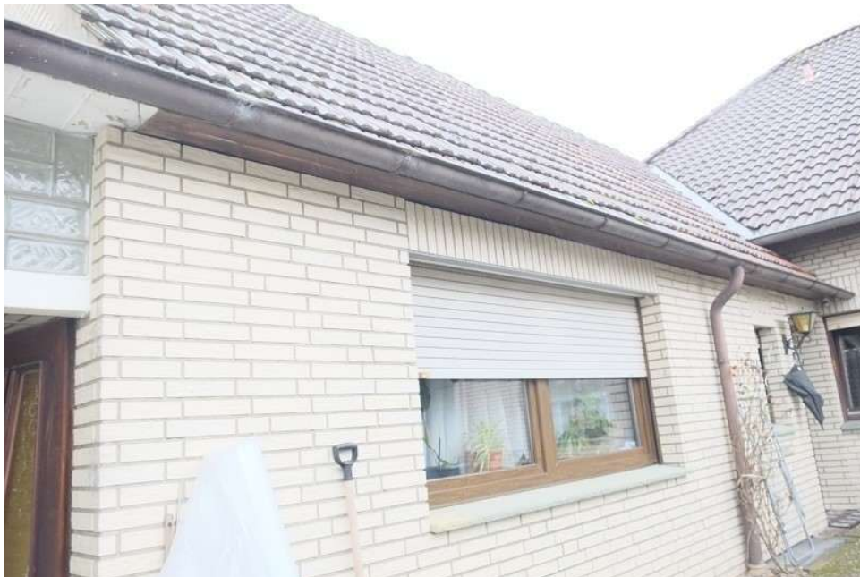
Bild 4: Blick auf die Dachfläche Teutoburger Weg Nr. 49b
