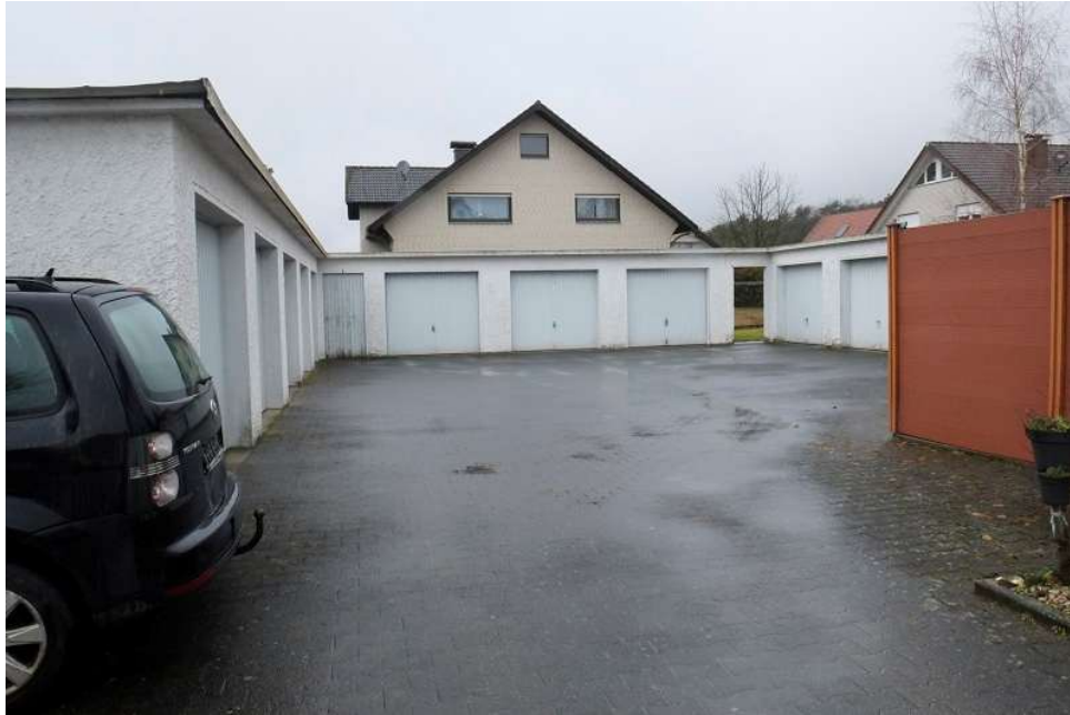
Bild 9: Blick auf den Garagenhof
