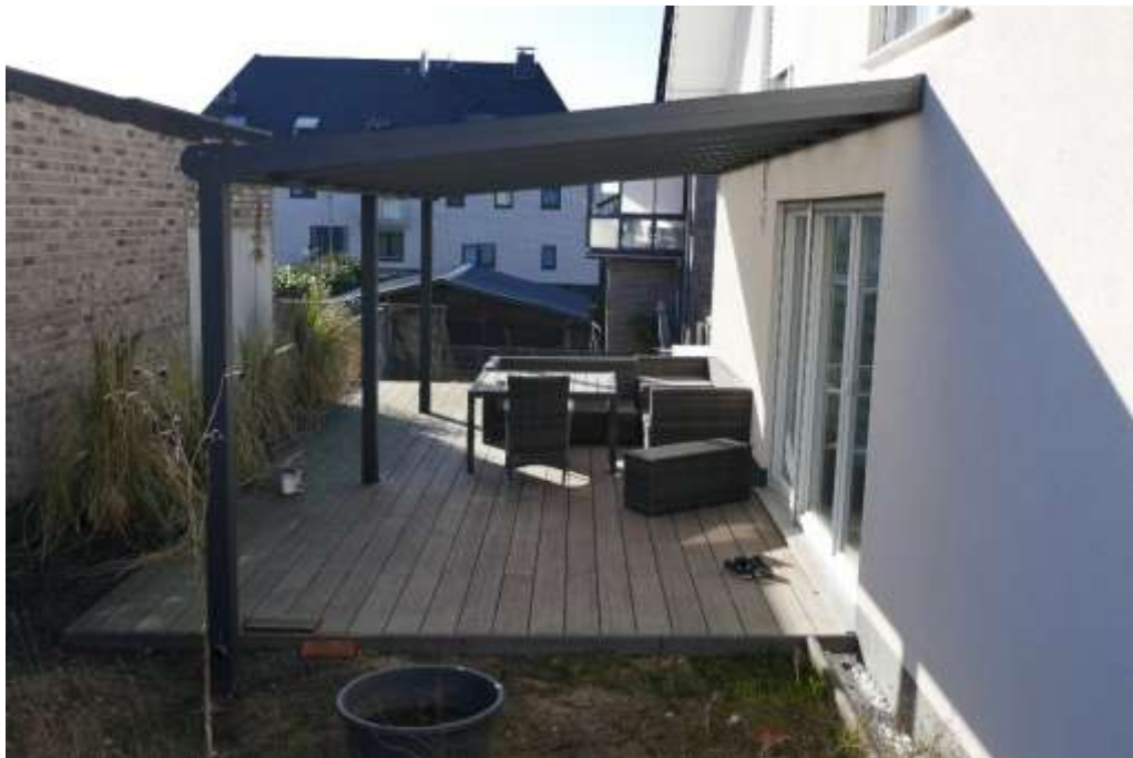
Überdachte Terrasse an der Südseite
