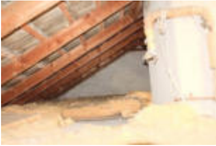
Blick in den Dachboden
