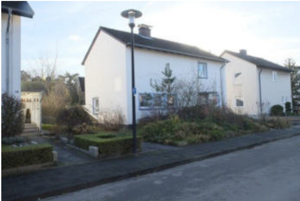
Bild 3: Blick auf das Grundstück
