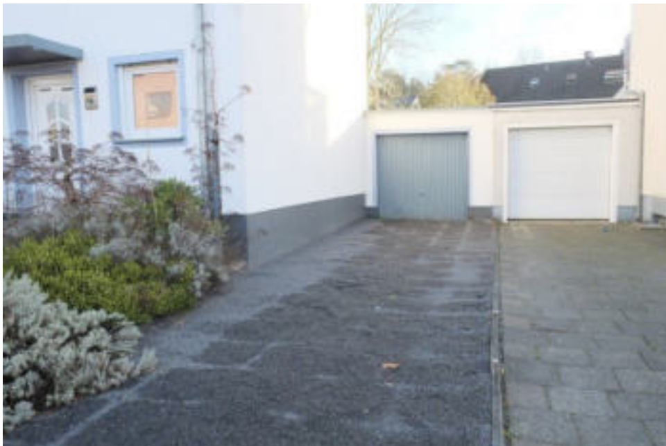
Bild 6: Zufahrt in die Garage
