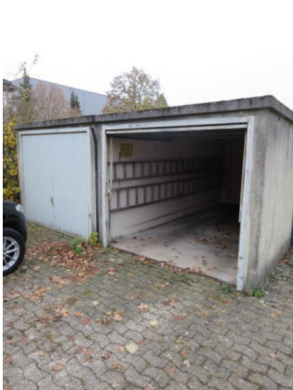
Garagen (Ansicht Südwest)
