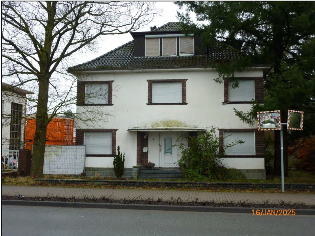
Wohnhaus – Ansicht von Südwesten
