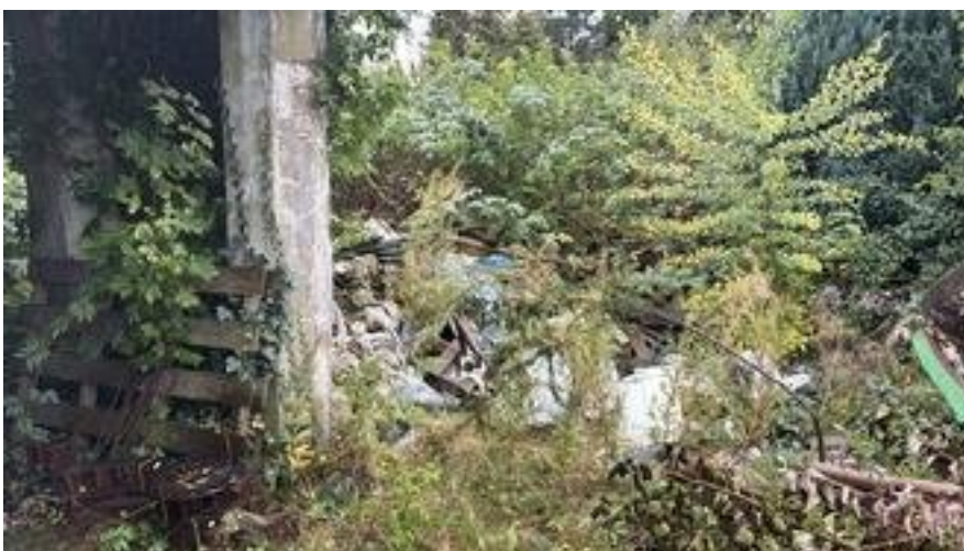
Bauschuttablagerung im hausnahen Bereich
