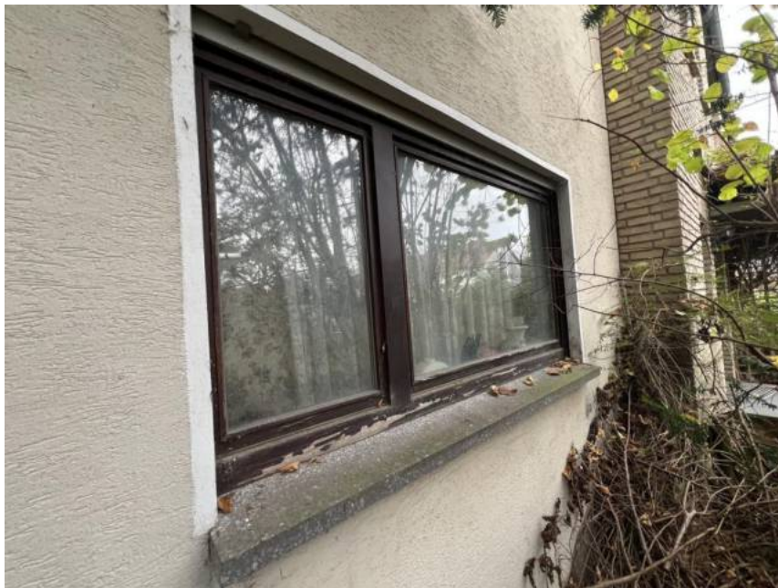
Holzfenster (Küche Erdgeschoss)
