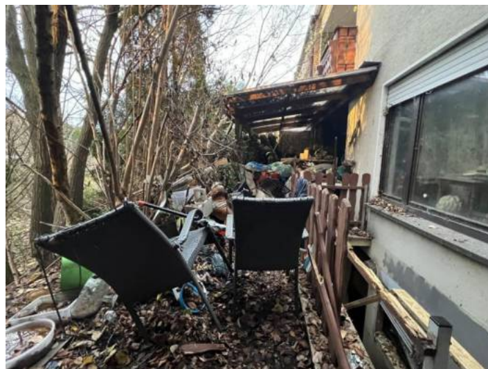
Blick auf die überdachte Terrasse (zugemüllt)
