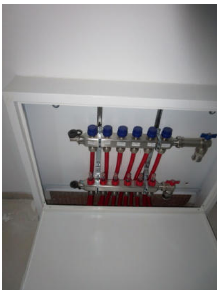
Verteiler Fußbodenheizung (EG)
