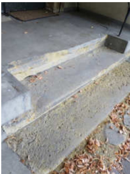
Schäden am Treppenaufgang
