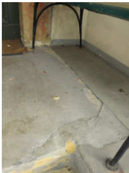
Schäden am Eingangspodest
