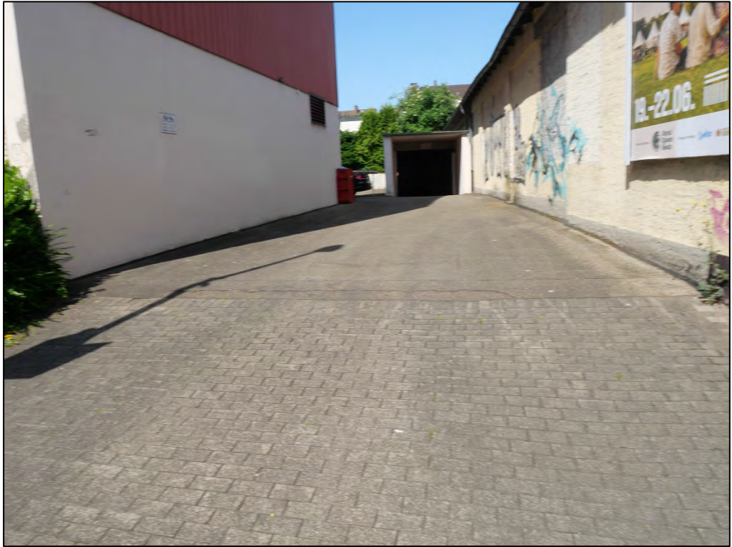
Zufahrtssituation zur Tiefgarage
