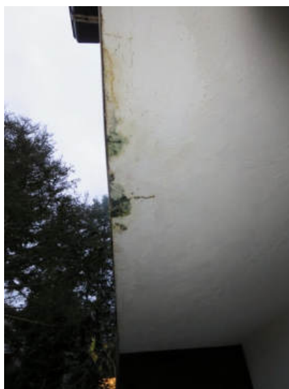
Feuchtigkeitsschaden (Balkon) verwitterte Holzpaneele
