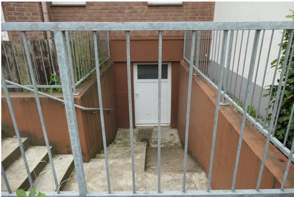
Bild 8: Kelleraußentreppe mit Rampe zum Fahrradkeller / unterhalb der Wohnung Nr. 18
