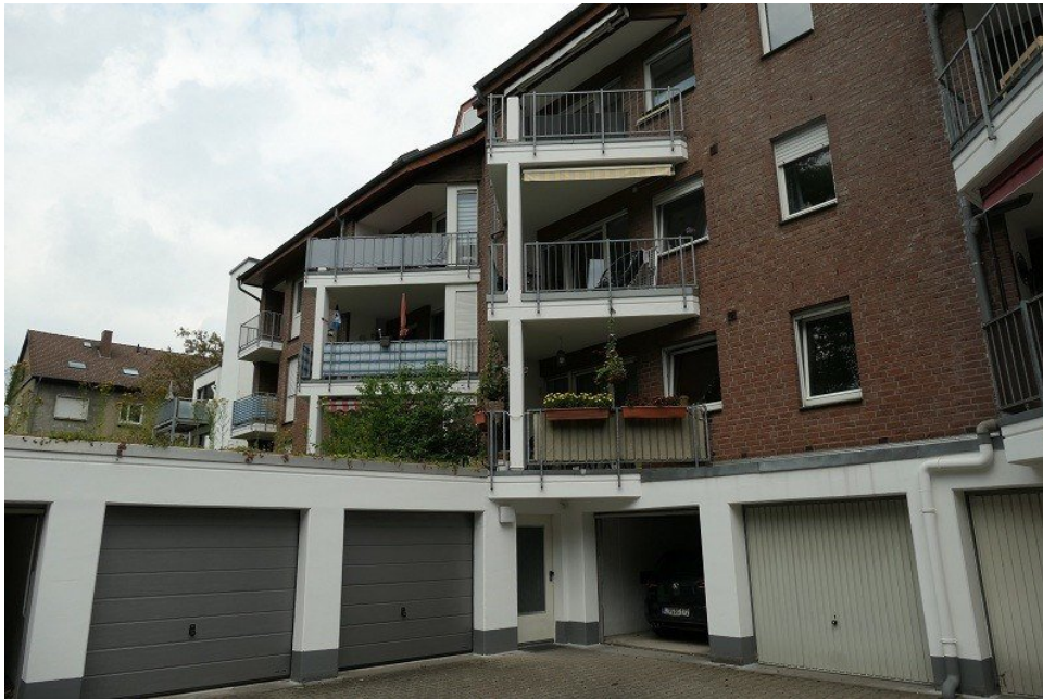
Bild 3: Ansicht von der Hofseite
