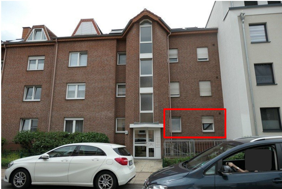
Bild 1: Ansicht von der Straßenseite mit Kennzeichnung der Lage des Sondereigentums
