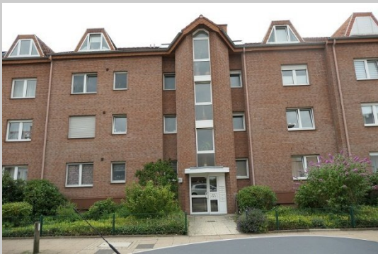
Blick auf den eingezäunten Vorgarten
