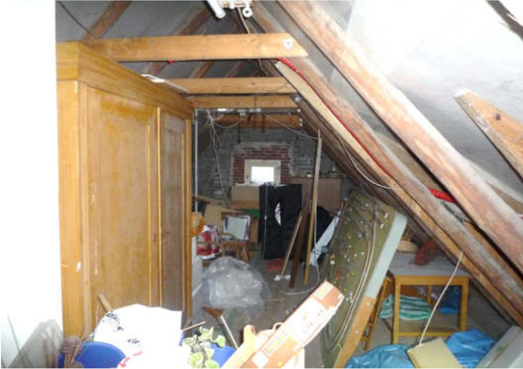
Spitzboden: Feuchtigkeitsschäden aufgrund offenem Dachdurchbruch
