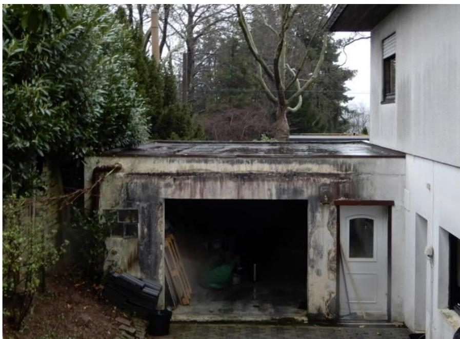
Rückansicht Garage/durchfeuchtetes Mauerwerk
