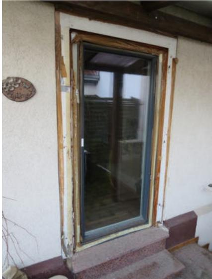
schadhaftes Fensterelement (Anbau) Kelleraußenzugang
