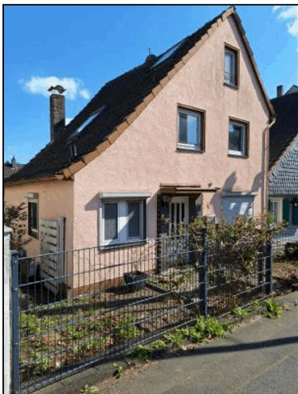
Ein freistehendes Einfamilienhaus mit eineinhalb Geschossen, Schleppdach, Teilunterkellerung und unterkellertes Terrasse. Das Gebäude wurde vermutlich ursprünglich vor 1900 erbaut. Im Jahr 1968 wurden die Außenwände in massiver Bauweise neu errichtet. Die Innenwände entsprechen noch dem Baujahr und sind in Fachwerk ausgeführt.
