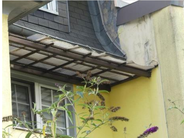
Balkonüberdachung beschädigt
