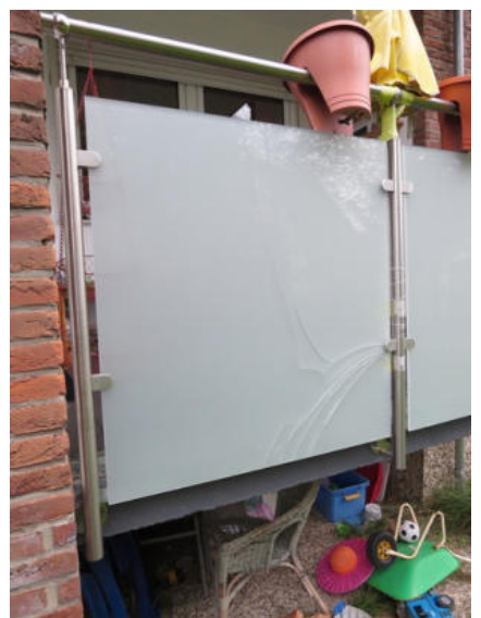
Schaden Balkonbrüstung
